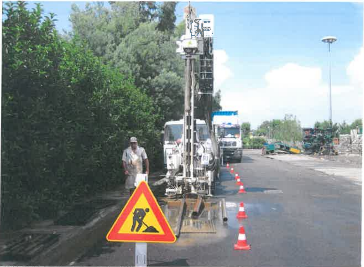
FOTO "53": sondaggio geognostico S13.
