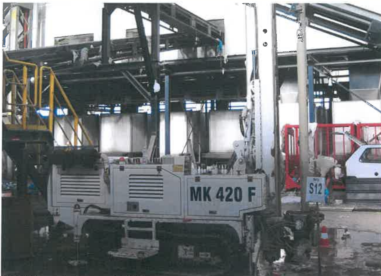
FOTO "49": sondaggio geognostico S12.
