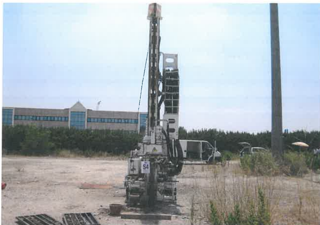
FOTO "15" : sondaggio geognostico S4.
