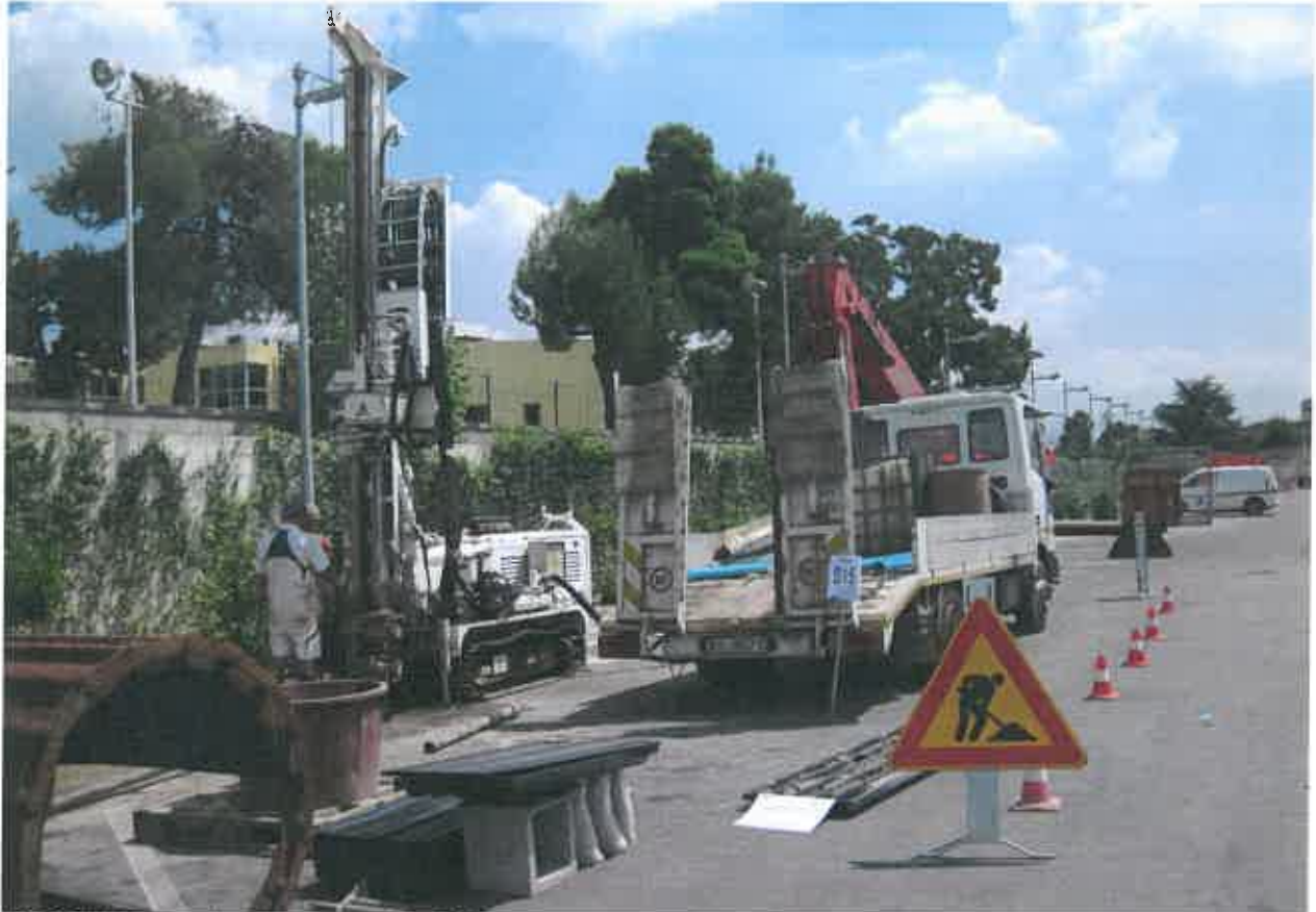
FOTO "63": sondaggio geognostico S15.
