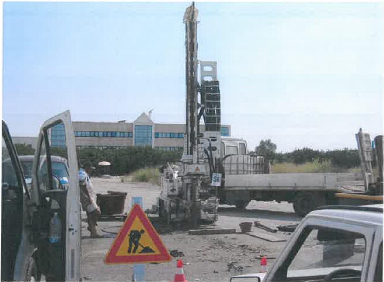
FOTO "25": sondaggio geognostico S6.
