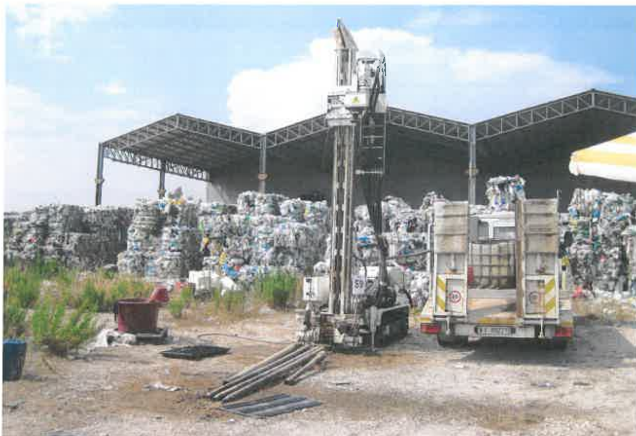
FOTO "37": sondaggio geognostico S9.
