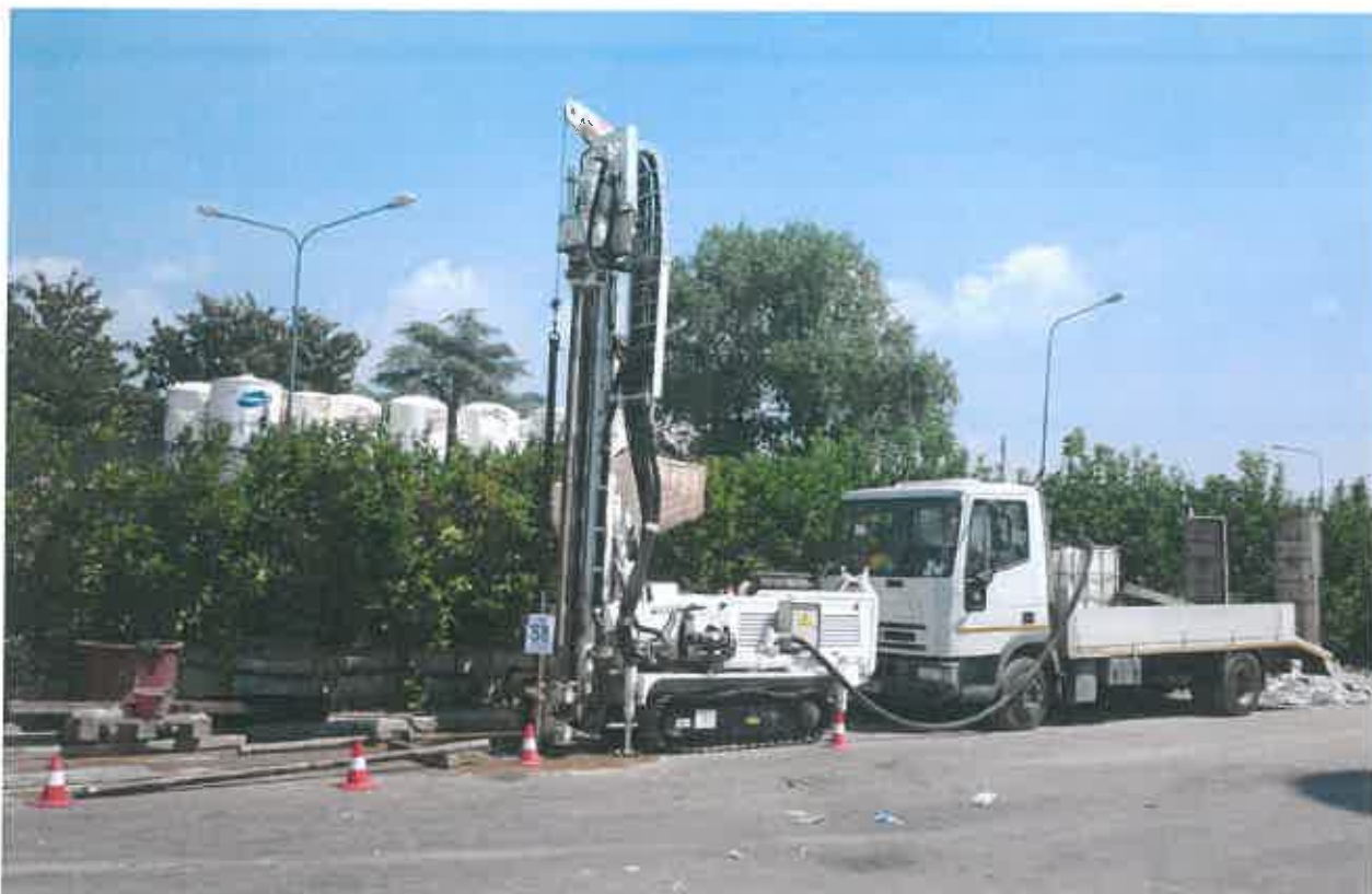
FOTO "33": sondaggio geognostico S8.
