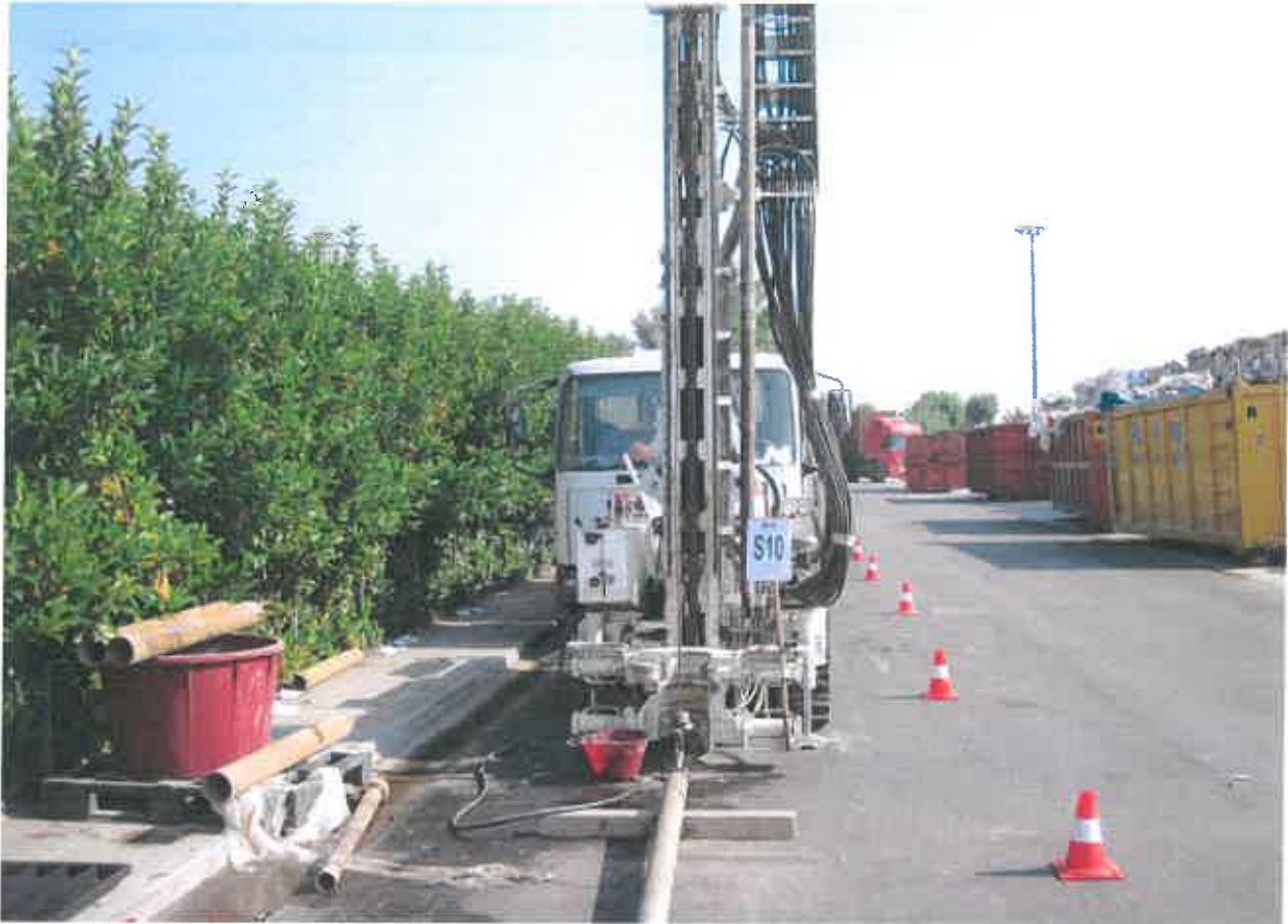
FOTO "41": sondaggio geognostico S10.
