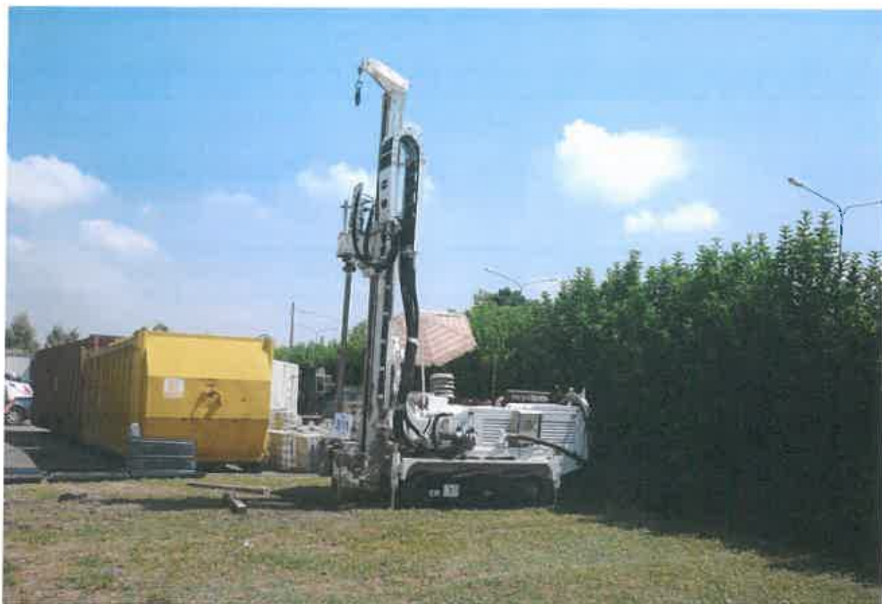
FOTO "45": sondaggio geognostico S11.
