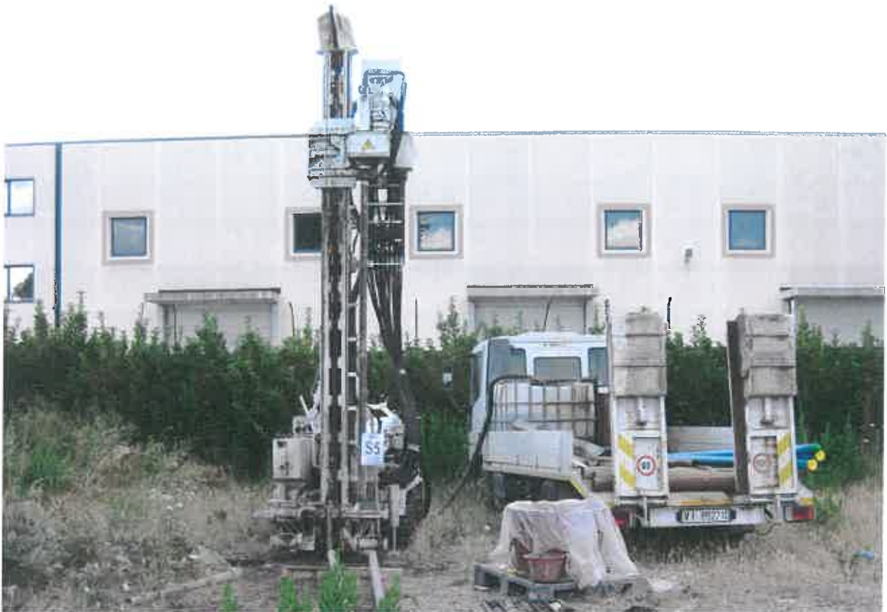
FOTO "19": sondaggio geognostico S5.
