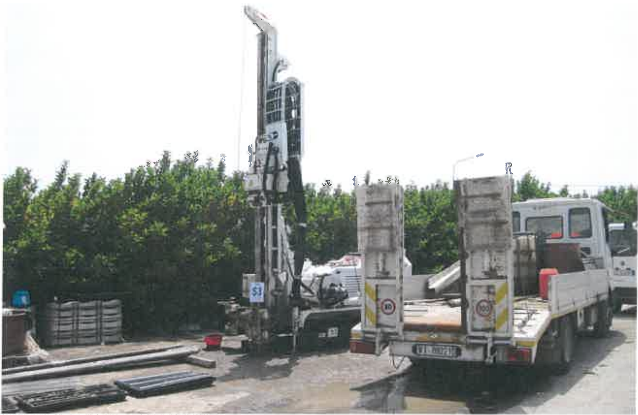
FOTO "9": sondaggio geognostico S3.
