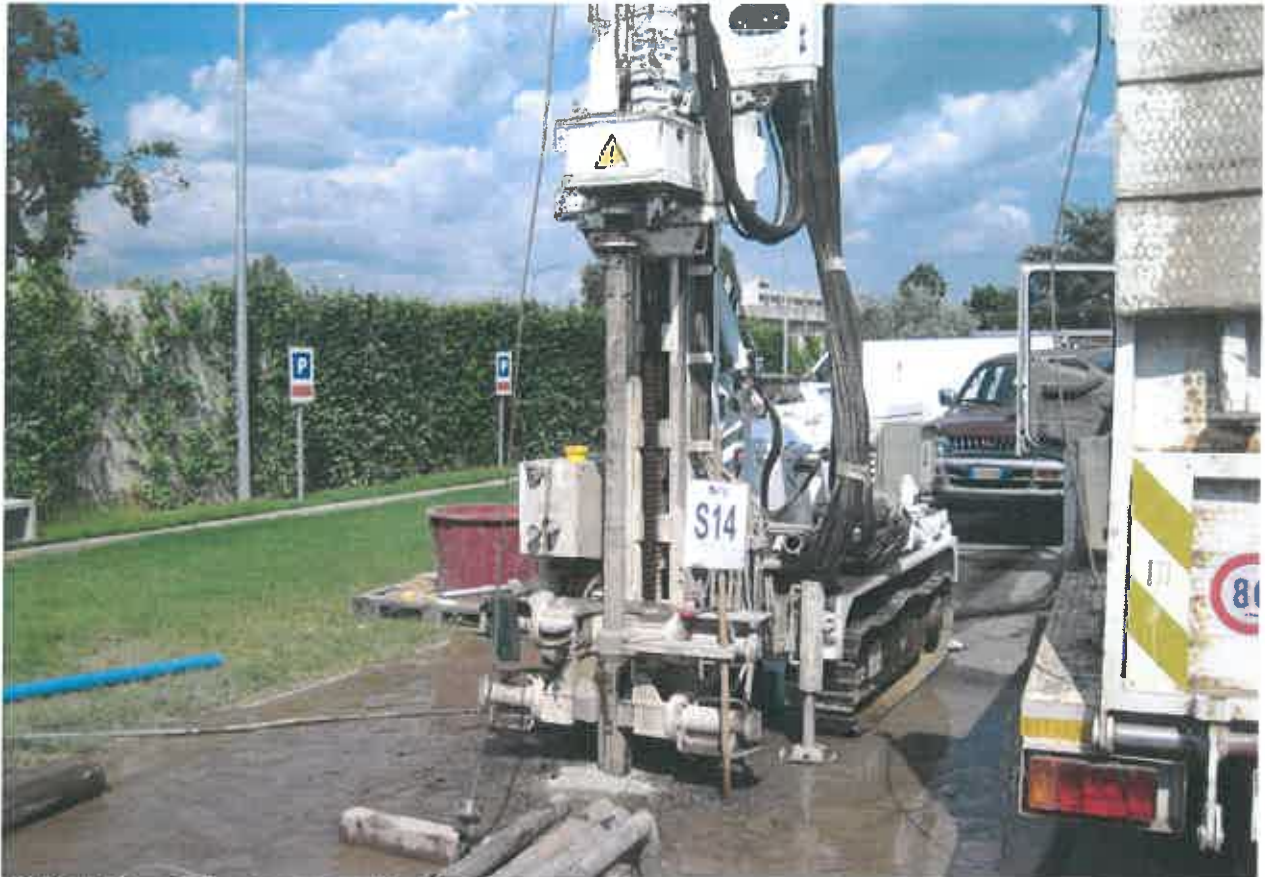
FOTO "57": sondaggio geognostico S14.
