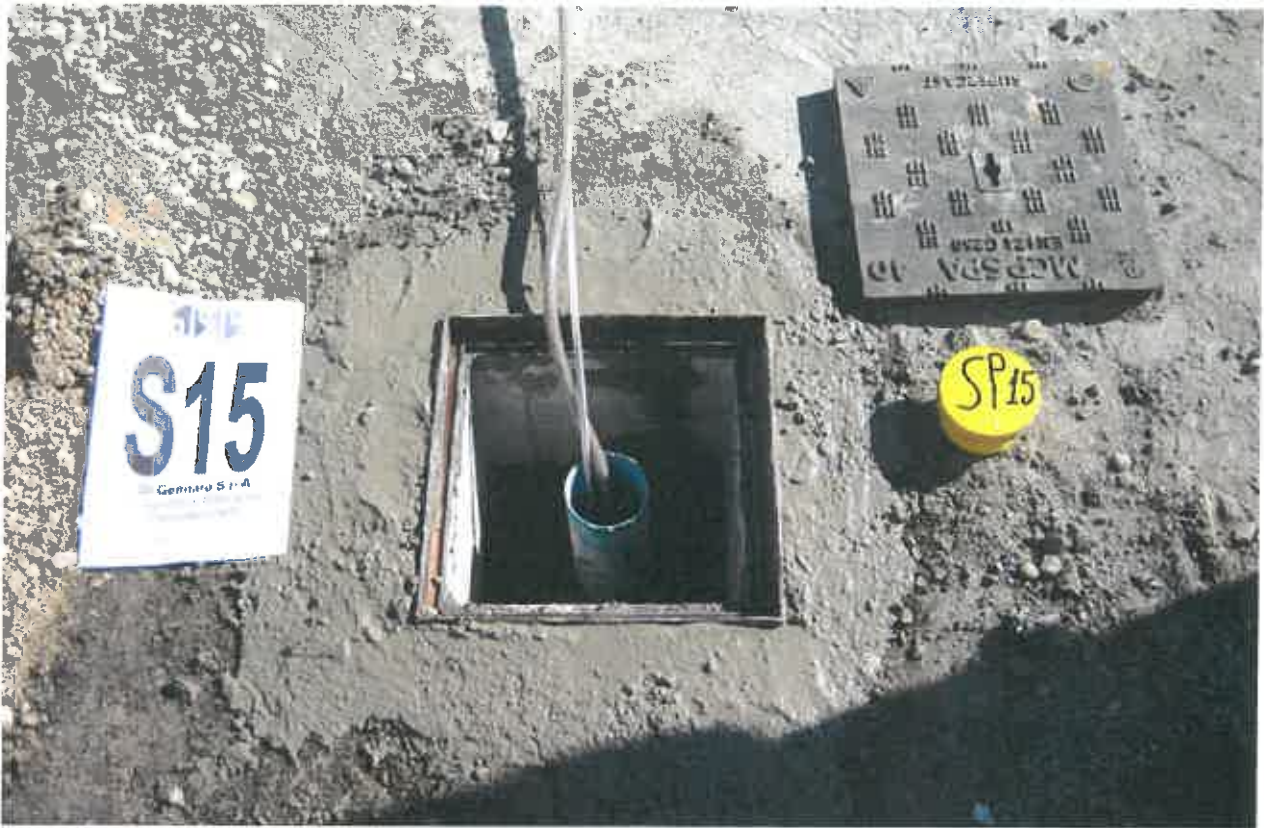
FOTO "67": Pozzetto per condizionamento SP15
