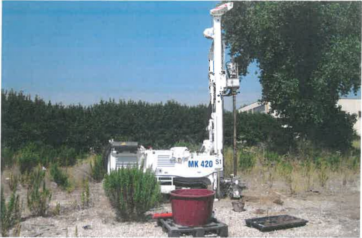
FOTO "1": sondaggio geognostico S1.
