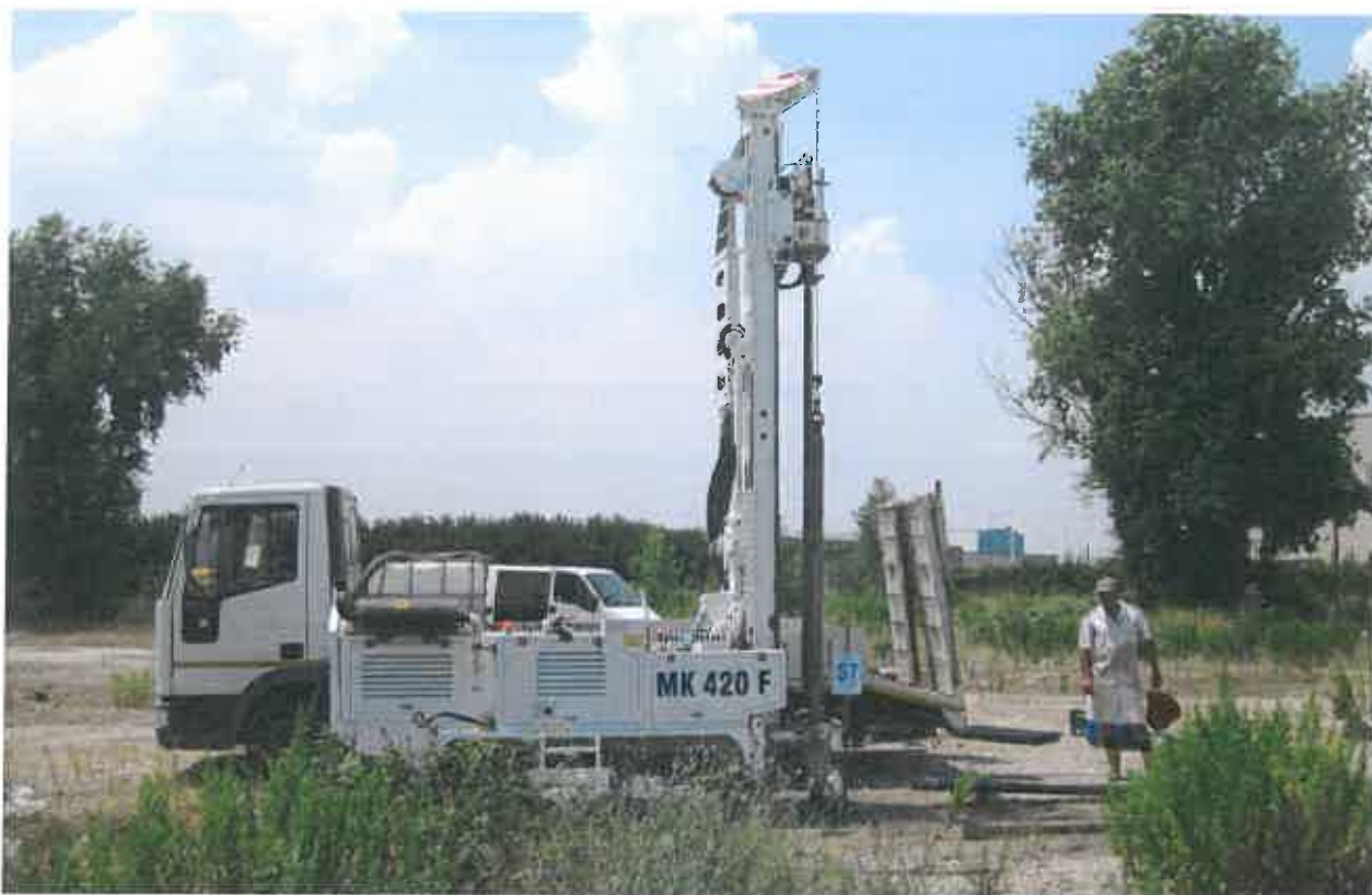
FOTO "29": sondaggio geognostico S7.
